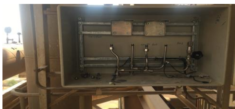
شکل ۱۱. جعبه باکس محلی و اتصالات آن
