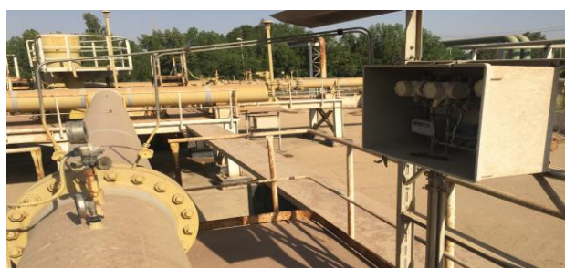
شکل ۷. فلومتر اوریفیس پلیت واقع در ایستگاه گاز نیروگاه
