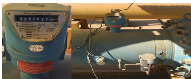
شکل ۶. فلومترهای توربینی واقع در ایستگاه گاز نیروگاه
