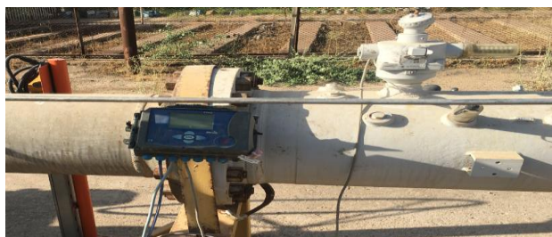
شکل ۵. تصحیح کننده فلومتر توربینی در ایستگاه تقلیل CGS
