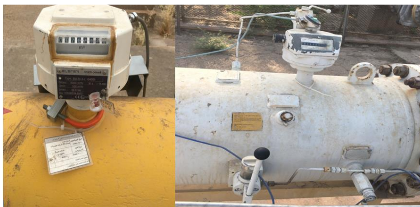
شکل ۴. فلومترهای توربینی واقع در ایستگاه تقلیل CGS
