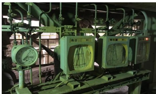
شکل ۸- نصب و راه اندازی گیج اختلاف فشار روسی جدید
