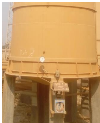
شکل ۱۱- نصب و راه اندازی گیج های فشار لوله ورودی
